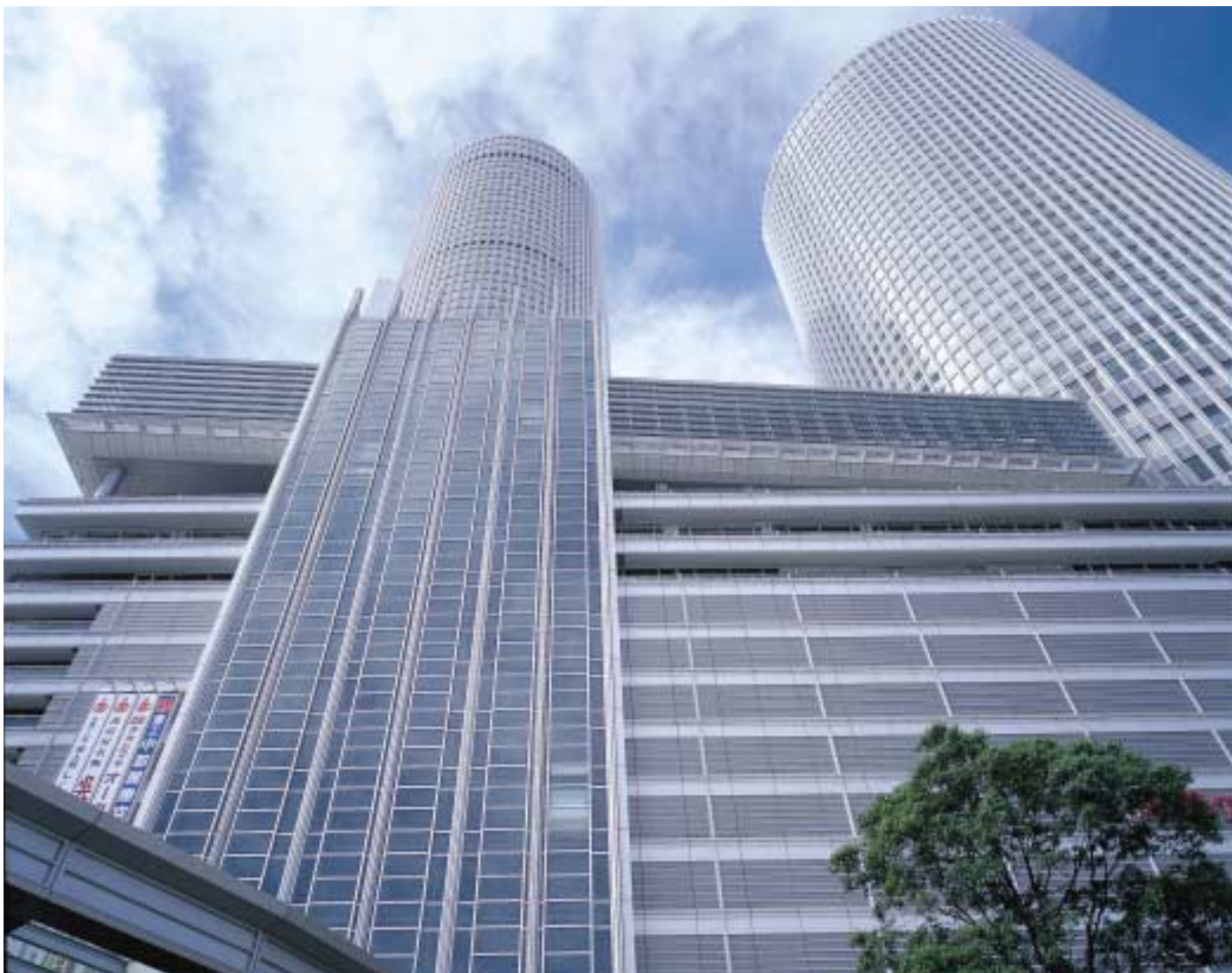
JRセントラルタワーズ（名古屋市）
