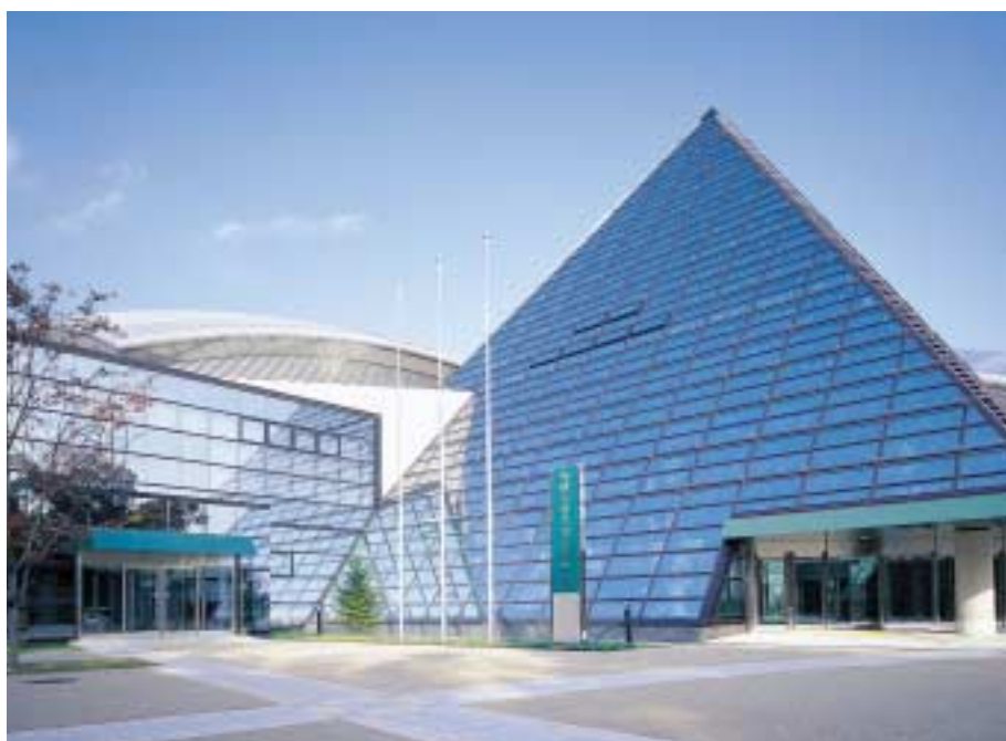
橋本体育館 (和歌山・橋本市) / ベアレックス
