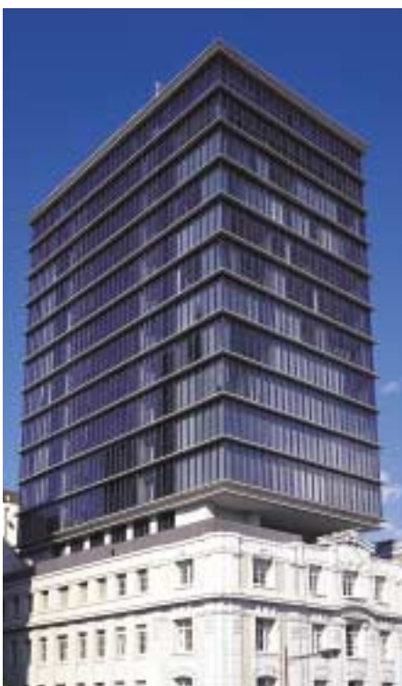
神戸海岸ビル(神戸市) / グレーラル
